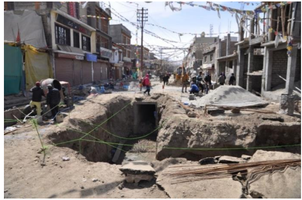
Abb. 3: Bauarbeiten Main Bazaar J. Müller, 12.04.15
